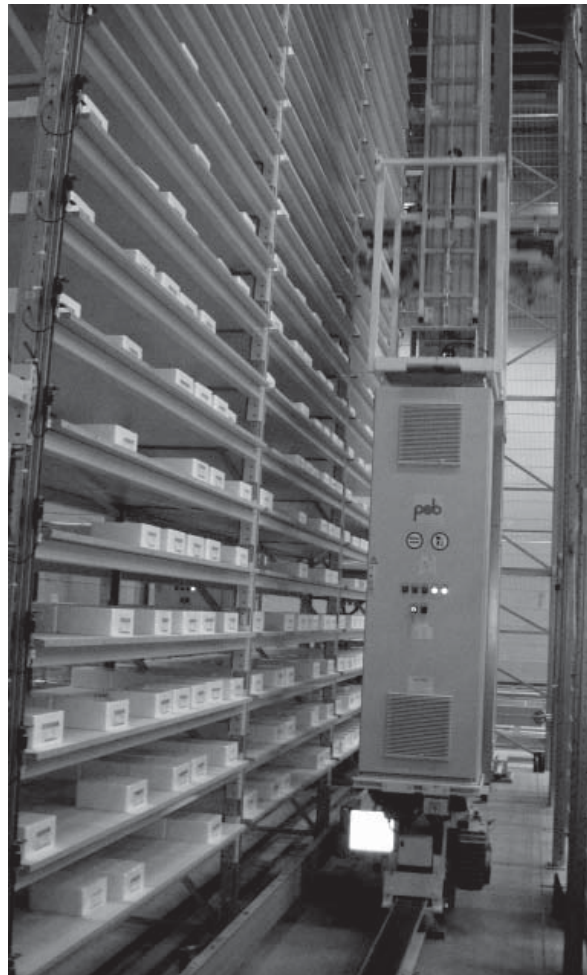
Bei der Inbetriebnahme ... During the commissioning ...
